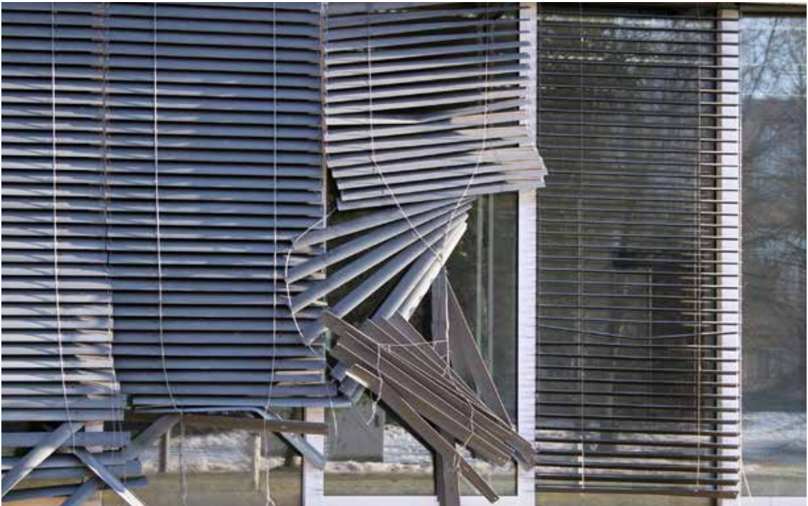
Storen sind bei Unwetter besonders gefährdet. Bei Sturm- und Hagelwarnungen rechtzeitig hochziehen.
