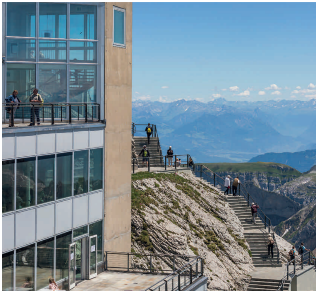
Gut signalisierte Fluchtwege führen die Gäste im Notfall nach draussen.
