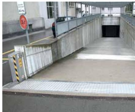
**Automatisches Klappschott vor Tiefgarage**
