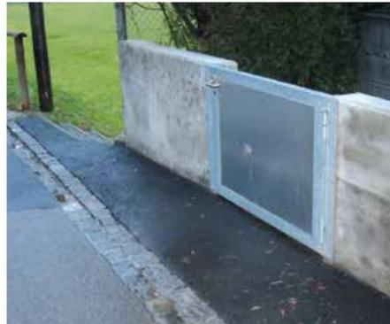
**Wasserdichter Eingang in Betonmauer**
